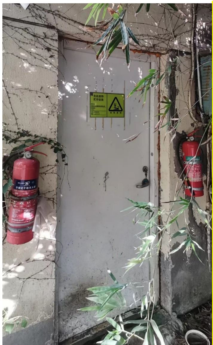
图 3-10 危废暂存场所图
